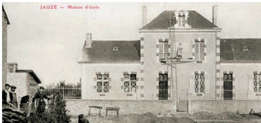
La mairie-école en construction, 1906. Carte postale L.Vivien. Archives départementales de la Sarthe : 2 FI 6235
