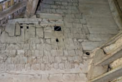
Le Hidoux, rare exemple conservé de couverture en bardeaux de bois sur l'ancien pignon du logis (détail)
