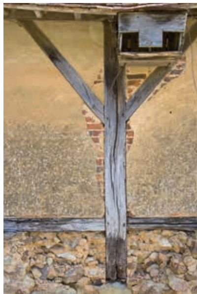
La Hanterie, détail de pan-de-bois hourdé de briques enduites
