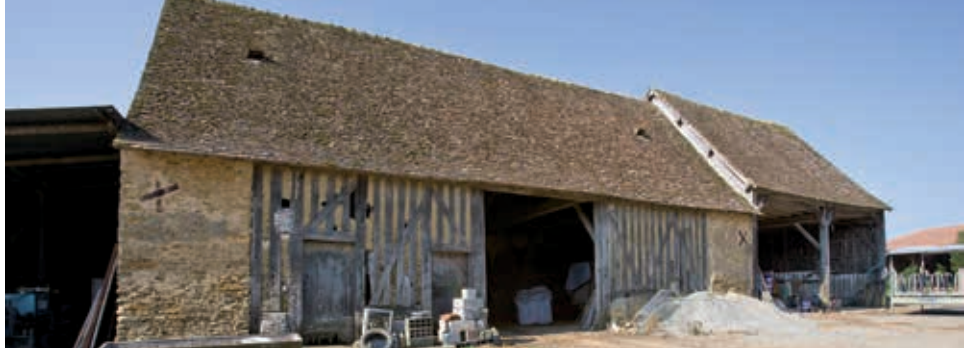
Le Hidoux, grange-étables et charreterie
