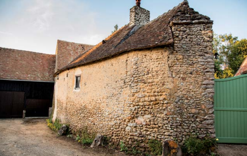
Cour Cherruau, détail du mur d'enceinte du 18 rue Notre-Dame.
