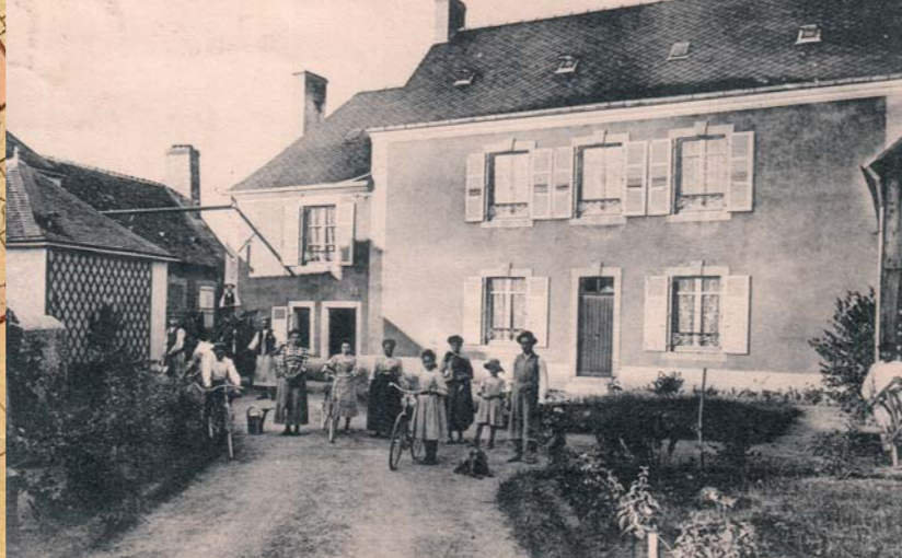
Site du prieuré de Torcé, ancienne fromagerie au début du XX e siècle.
