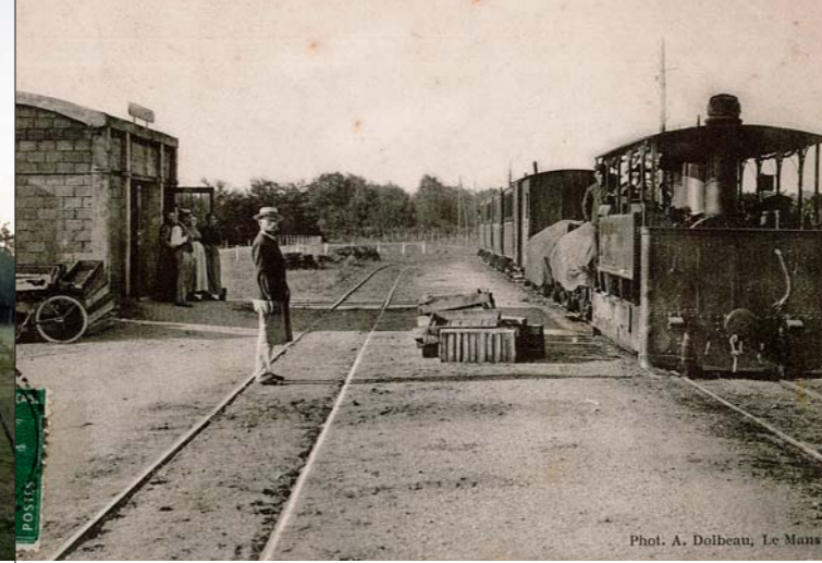
L'ancienne gare de tramway, en fonctionnement jusqu'en 1947.
