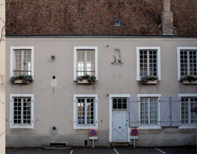
Ancien presbytère, place de la Mairie.
