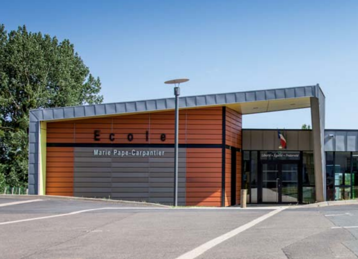
Groupe scolaire Marie-Pape Carpentier, école élémentaire.
