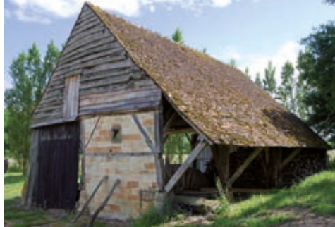
Hangar agricole sur poteaux des Bommeries, seconde moitié du XIX e siècle.
