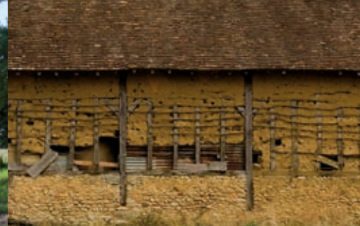
La grange édifée vers 1868 à La Pichinière offre un bel exemple de mise en œuvre rationalisée du pan-de-bois.
