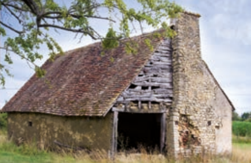
La partie droite du mur-pignon du logis de La Maison Blanche, la cheminée et une partie de la façade sont en maçonnerie de moellons. La partie gauche et l'élévation postérieure, en pan-de-bois enduit de terre, étaient ornés d'un lait de chaux.
