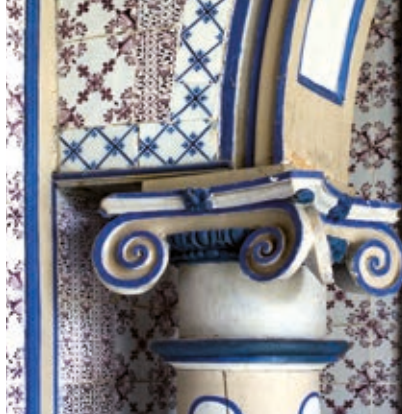
Détail de l'une des alcôves du cabinet de bains du château. L'arc, porté par une colonne et un chapiteau en bois peint, et le mur sont revêtus de carreaux céramiques.
