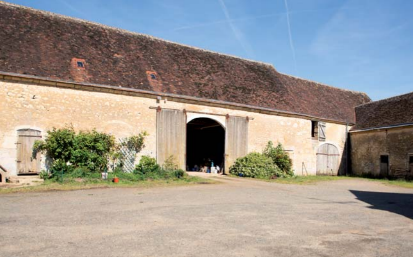
Bâtiments agricoles de la Métairie.
