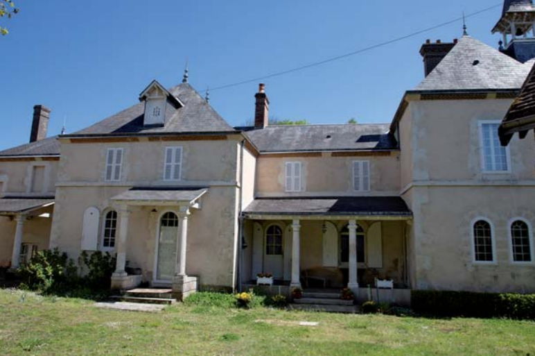
Le Chêne Creux, façade du logis.
