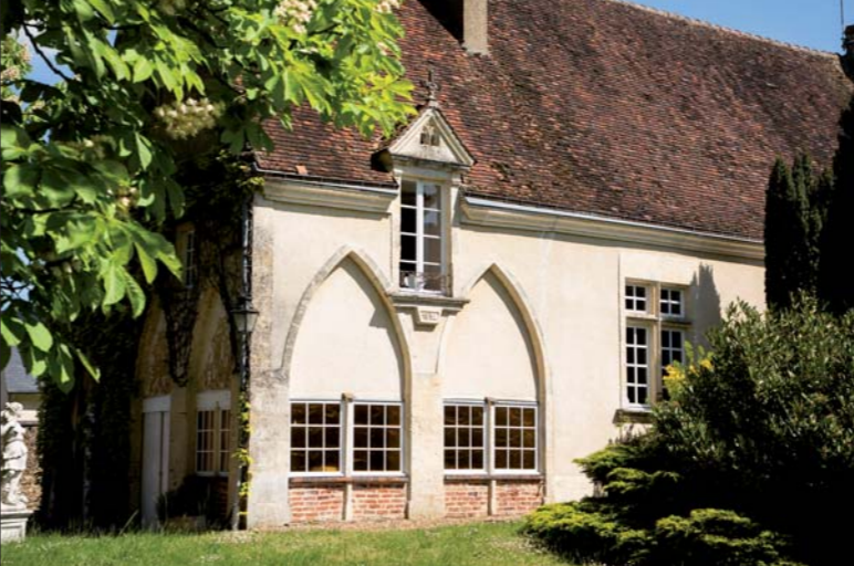
Le Paradis, vue de la façade depuis le sud-ouest.
