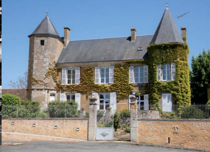
Ancien manoir, presbytère sous l'Ancien Régime.
