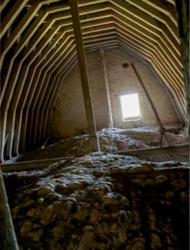
Combles de l'église.
