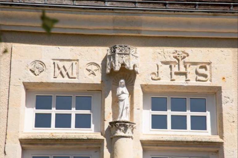
Le Paradis, ancien presbytère, détails sculptés de la porte d'entrée.
