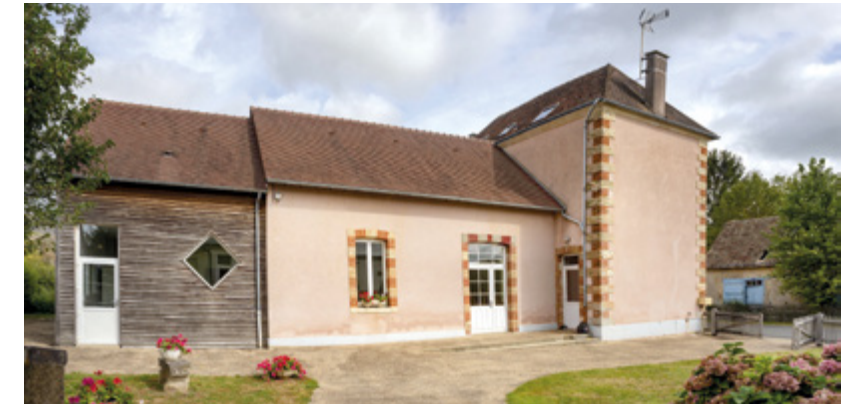
Ancienne école construite entre 1869 et 1872, actuellement logement communal et salle des fêtes, avec l'extension créée en 2010 (© Région Pays de la Loire, Inventaire Général, P-B Fourny).
