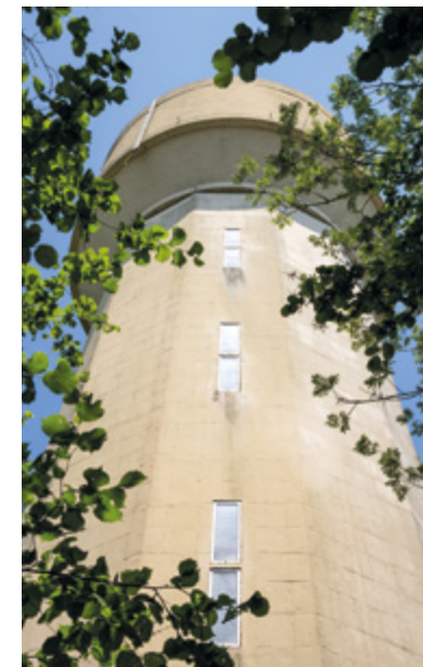
Château d'eau construit en 1966 (© Région Pays de la Loire, Inventaire Général, T. Seldubuisson).
