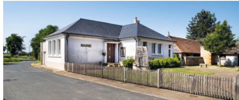
Ancienne cantine scolaire et mairie construites en 1958 (© Région Pays de la Loire, Inventaire Général, T. Seldubuisson).
