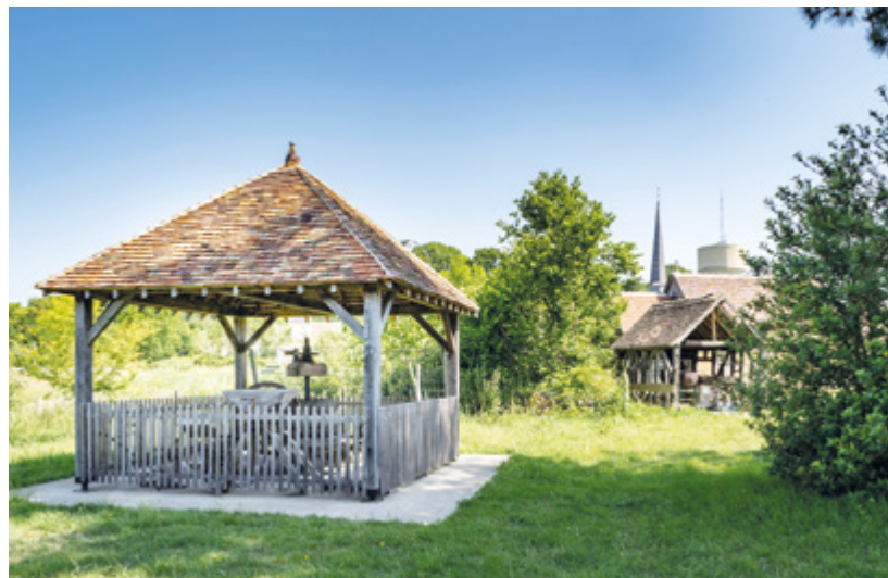
Abri du pressoir construit en 2020 (© Région Pays de la Loire, Inventaire Général, T. Seldubuisson).
