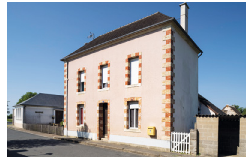
Ancien logement des instituteurs (© Région Pays de la Loire, Inventaire Général, T. Seldubuisson).
