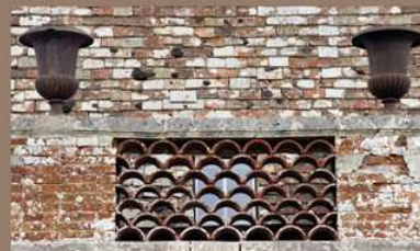
> 3 La brique creuse, apparue dans la deuxième moitié du XIX e siècle, est préférée pour le gros œuvre en brique, qui reste peu fréquent. Jauzé, La Fontaine, étables, limite des XIX e et XX e siècles.
