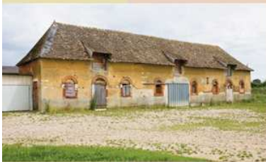
> 2 La Mandinière, à Courcival, étables construites vers 1860 en raison de l'essor de l'élevage bovin.
