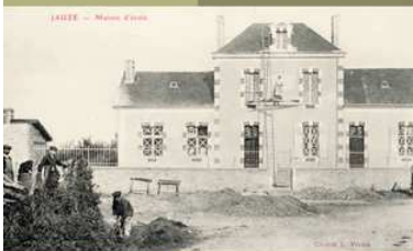
> 3 Mairie-école de Jouzé, entre 1904 et 1906. L'architecte Legendre conçoit un corps central à étage pour le logement de l'instuteur et deux ailes pour les classes et la mairie.
