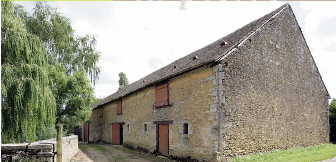
> 1 Exemple de bâtiment construit en moellons avec chaînes d'angles en pierre de taille. Jauzé, La Cour, grange-étable-fénil, vers 1840.
