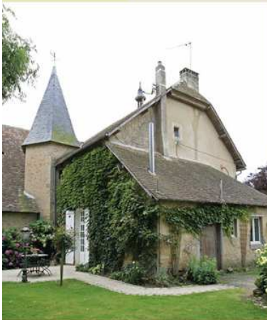
> 2 Logis du manoir de la Paysanterie à Jauzé, deuxième moitié du XV e siècle. Constitué en moellons et pans-de-bois, il comprend deux corps de bâtiments en équerre, desservis par une tour renfermant l'escalier en vis. Le corps principal est remanié vers 1939.
