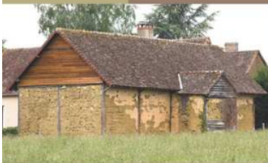
> 3 Grange des Bommeries, à Courcival, construite en 1860, le pan-de-bois est organisé en traverses larges, les bois sont minces et soies méconiquement.
