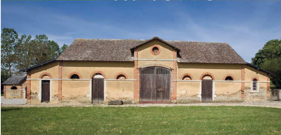
> 1 Grange-étables avec chaînes en briques et couverture de tuiles plates. Courcival, Le château, troisième quart du XIX e siècle.
