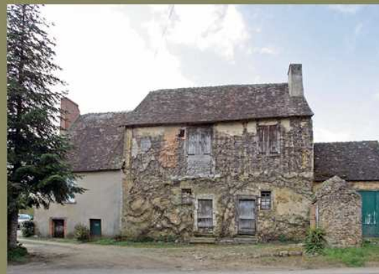
> 3 Logis du Borfage, Brienne-les-Sables, 1613. Maison de notable composée d'un rez-de-chaussée en moellons et d'un étage en pans-de-bois.
