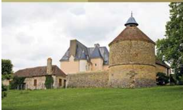
> 3 Haut-Eclair à Nogent-le-Bernard, quatrième quart du XVI e siècle. L'édifice imite la disposition des manoirs de la période précédente, et s'en distingue par ses élévations à travées et son haut toit à croupes.
