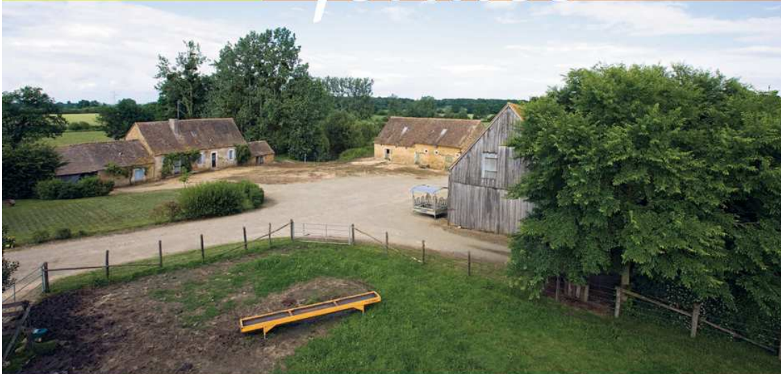
> 1 Ferme du Hidoux à Terrehault. Bâtimens en moellons ou en pans-de-bois, construits entre les XV e et XIX e siècles autour d'une cour qui comprend également la mare et le puits.
