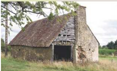
> 2 Exemple de logis à pignon construit partie en pan-de-bois, partie en moellons. La Maison Blanche, à Courcival, XVIII e siècle.
