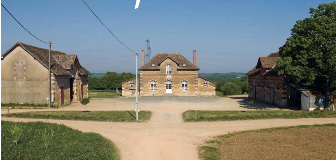
> 1 Mèreau à Brisne-lès-Sables, l'une des fermes du domaine du château de Bonnétable reconstruites vers 1850 selon un plan-type. Dessiné par un architecte, l'édifice est organisé selon un axe de symétrie autour d'une cour régulière.
