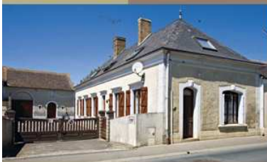
> 3 Largement utilisée au XIX e siècle, la pierre de taille permet de varier le revêtement des baies et de créer corniches et bandeaux. Ruperroux-le-Coquet, Le Bourg. Maison et écurie-remise.
