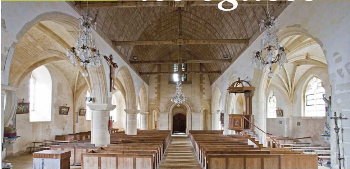
> 1 Intérieur de l'église Saint-Jouin de Nogent-le-Bernard depuis le chœur. Nef couverte d'une fausse-voûte lambrissée, les bas-côtés sont couverts de voûtes d'ogives, la première travée de la nef est surmontée d'une tour-clocher vers 1850.
