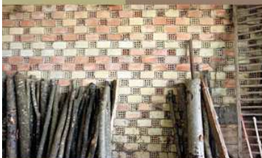
> 3 La brique creuse, apparue dans la deuxième moitié du XIX e siècle, est préférée pour le gros œuvre en brique, qui reste peu fréquent. Jauzé, La Fontaine, étables, limite des XIX e et XX e siècles.
