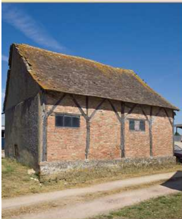
> 2 La brique est également employée pour clore les petits bâtiments sur poteaux de bois. Brienne-le-Sablon, Bois d'Atilly, remise, XIX e siècle.
