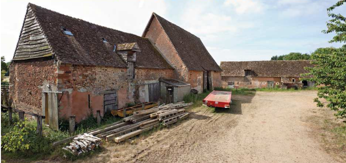
> 1 La Moinerie à Brienne-lès-Sables. À gauche grange-étable du XVI e siècle, prolongée par des étables du XVII e siècle (?). En fond de cour, le bâtiment abritait, en 1741, une étable et deux petites granges. La ferme comprend également un bâtiment remanié en porcherie au XIX e siècle.
