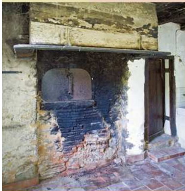
> 2 L'Angellerie à Terrehault, cheminée. La cheminée est généralement engagée dans le mur et comprend une hotte droite en moellons enduits sur un linteau de bois, reposant sur deux corbeaux taillés en quart de rond. La gueule du four est ouverte dans le contrecour, une planche fixée sur le linteau sert d'étagère.
