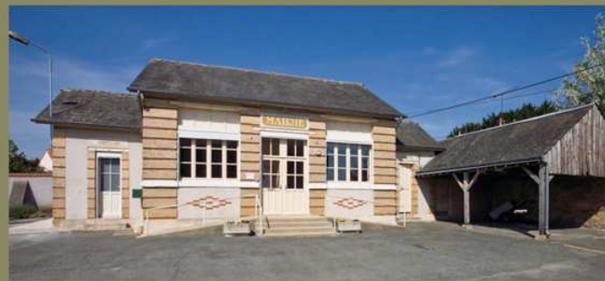
> 4 Mairie-école de Brissac, 1911-1912. L'architecte Lemeunier sépare logement et classes en deux bâtiments de part et d'autre de la cour de récréation, et utilise le fer pour couvrir les fenêtres des classes.
