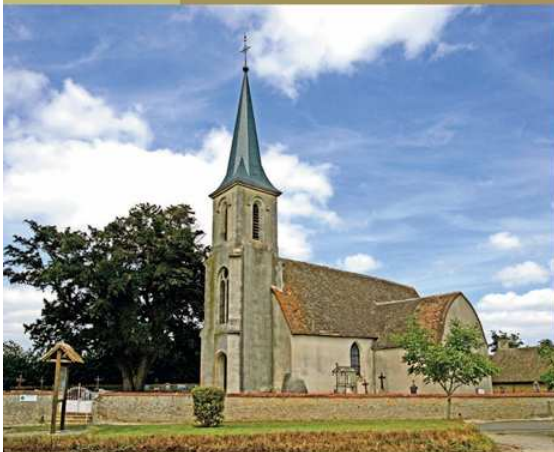
> 3 Église Saint-Barthélemy de Jouzé. Semblable à l'origine à celle de Terrehault, l'église est remaniée au XIX e siècle : réfection des toits, ajout du transept en 1823-1824 et de la tour-clocher en 1877.
