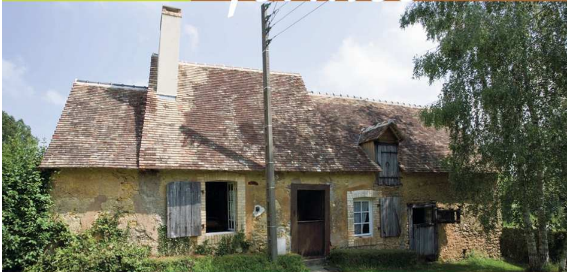
> 1 Logis de L'Angellerie, à Terrehault. La maison du XVI e ou XVII e siècle, repérable à la hauteur de son toit, est prolongée avant 1835 d'une chambre, avec étable. Les fenêtres sont refaites en briques au XIX e siècle.
