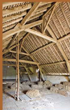
> 4 Le Martier Noir, Rouperroux, 1863. Les charpentes en carène construites à Jauzé vers 1820, celles, mâisées et boulonnées, des granges de Courcival vers 1860, ou celles posées sur jambes de forces ancrées dans le surcroît du mur, utilisées dès le XVIII e siècle, témoignent des recherches visant à augmenter le volume utile du comble.
