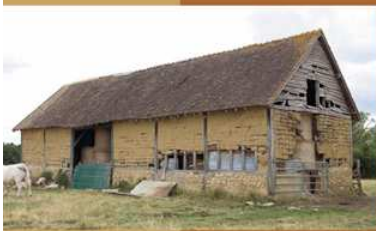
> 3 Grange de la Pichinière, Courcival, troisième quart du XIX e siècle. 7 granges identiques sont construites par le marquis de Courcival. Le pan-de-bois, dont l'ossature est rationalisée, est choisi pour sa solidité et son faible coût.
