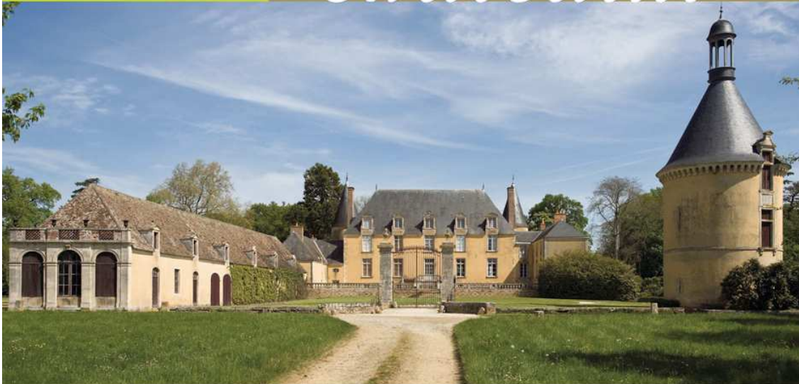
> 1 Unies dans une même composition au sein d'un vaste parc, la basse-cour et la cour du château de Courcival sont hiérarchisées par leur implantation sur des terrasses de hauteurs différentes. L'ensemble est remanié dans la deuxième moitié du XIX e siècle (tour de la basse-cour).
