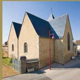
> 4 Église Saint-Martin de Rouperroux. L'église, d'origine romane, est modifiée entre le XV e et XVI e siècle : la nef est surélevée, le chœur reconstruit, un bas-côté ajouté sur le flanc sud de la nef.
