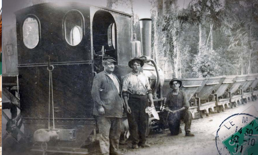
Utilisation du train Decauville lors des travaux de dérivation de la Bray, préalables à la construction de la de la ligne Pont-de-Braye - Blois
