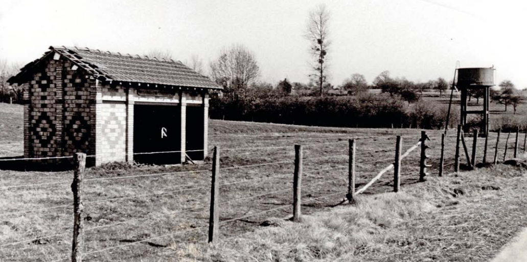
Gare du terminus Montmirail-État avec le château d'eau pour alimenter la machine à vapeur
