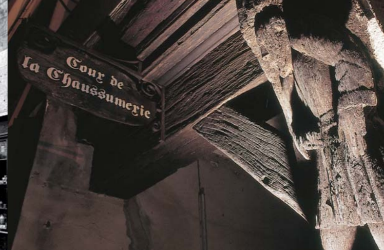
Straße rue d'Huisne, Zugang zum Hof Cour de la Chaussumerie, Wasserspeier.
