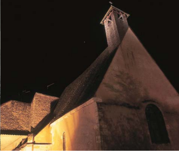
Die Kapelle Saint-Lyphard, die in den 1980er Jahren restauriert wurde, nachdem sie in den Besitz der Stadt übergegangen war und in 1981 in die Liste der Historischen Monumente aufgenommen wurde.
