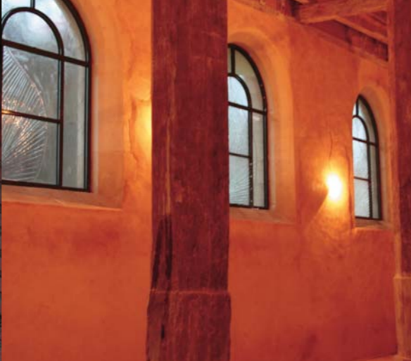
Halle Denis Béalet, Fenster im Erdgeschoss, angefertigt von Didier Alliou, Vitrail France, 2007.
