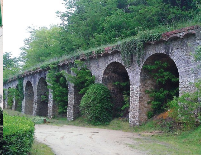
Viaduct in Savigné l'Évêque
